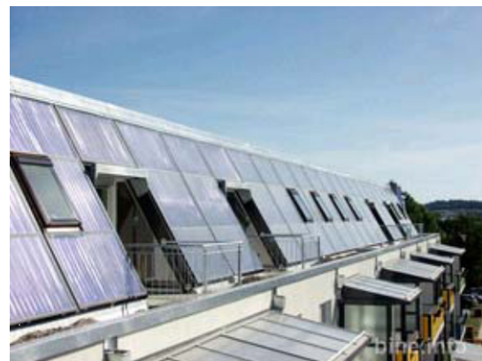
Bild: Kollektorfeld auf dem Dach des Nordflügels. Quelle: BINE
