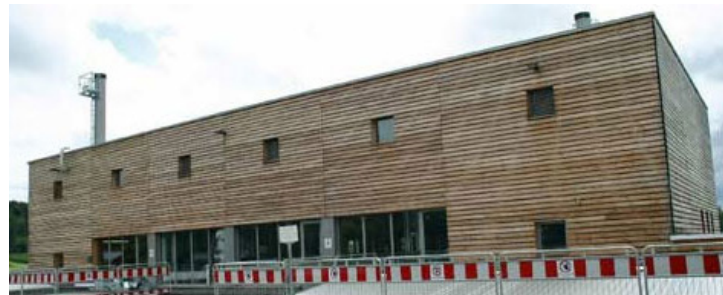
Bild 1: Neue Energiezentrale in Liebenau (Quelle: Ligas)
